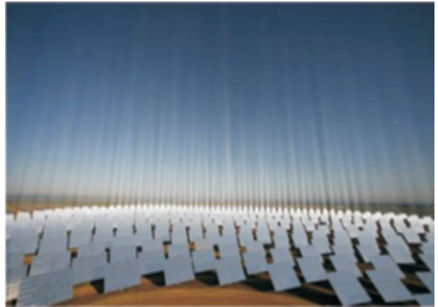
Công viên năng lượng mặt trời tại thành phố Seville, Tây Ban Nha, có thể sản xuất 11 triệu kW điện/năm
