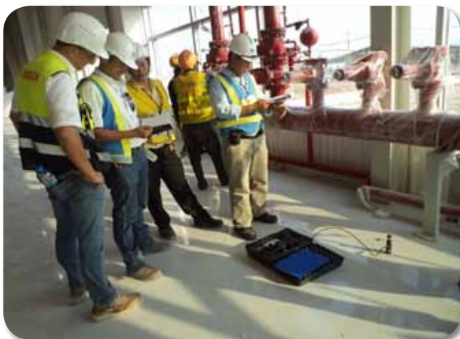
Kiểm tra chất lượng sản phẩm sau thi công tại dự án Nhà máy Robert Bosch.
