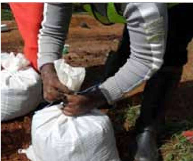
Bước 2: Đổ đất vào bao tải, buộc lại. Công đoạn buộc bao tải rất quan trọng, quyết định độ bền và sức chịu tải của bao sau khi đầm.
