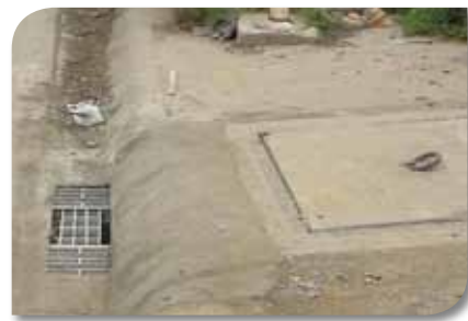
Miệng cống đã được cải tạo theo GPHI trên đường Nguyễn Ảnh Thủ, quận 12 cho thấy rác không còn trên miệng cống. Ảnh: Đồng Xuân Dũng.
