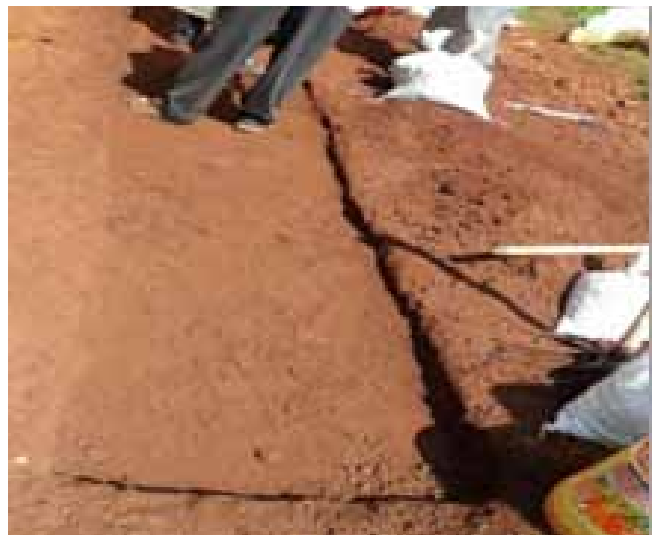
Bước 3: Đào rãnh sâu khoảng 10 - 25 cm trên đường để đặt bao. Loại bỏ các chướng ngại vật và vùng đọng nước.
