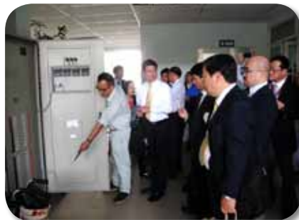
Hoạt động khảo sát lắp đặt hệ thống tủ quản lý năng lượng tại Bệnh viện 115.
