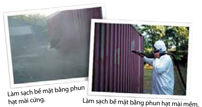
Hình 2: Sự khác biệt giữa phun hạt mài cứng so với hạt mềm.
