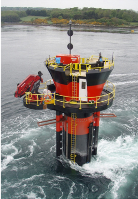
Nhà máy điện Strangford Lough Seagen (Anh) sử dụng công nghệ tuabin thủy triều
