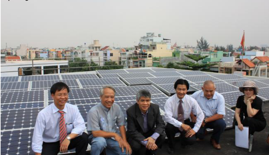
Dàn pin mặt trời 12,6 KWp tại công trình
