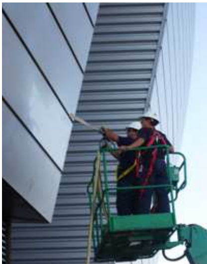
Dùng súng bắn băng khô để làm sạch sân vận động của trường đại học Phoenix, Mỹ sau trận cháy
